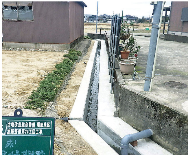
(県営農地整備事業 福田地区 荒見崎 4 号排水路の完成状況)
