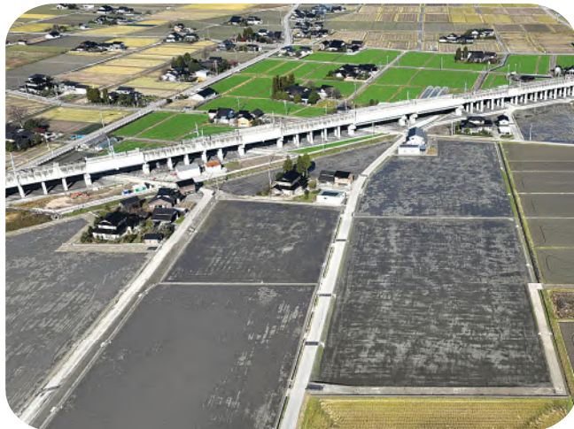
(県営農地整備事業 駒方地区 第1・2工区工事完成の様子)
